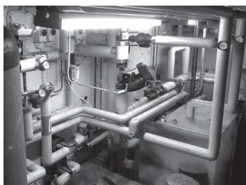
En del av pannrummet före...
